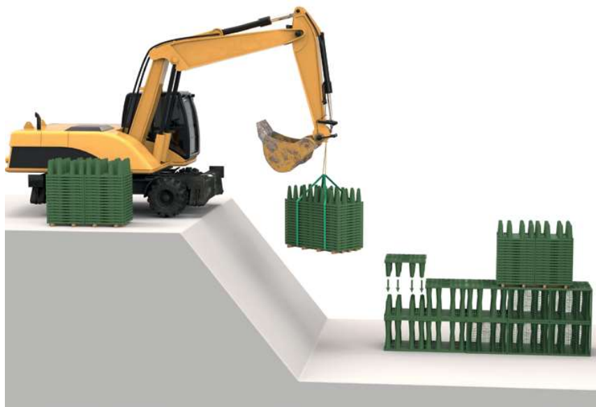
Montage dans la fouille
