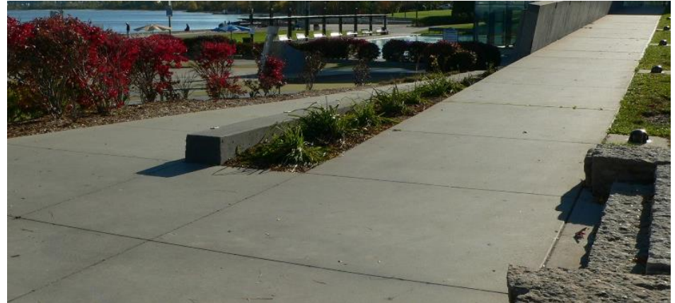
Barrier free ramp (3.1.12 & 3.1.13)
